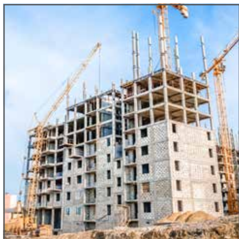
Alvenaria de vedação
